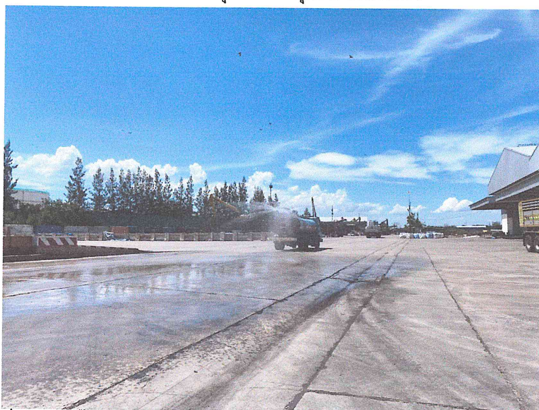
ภาพที่ 4 ใช้รถน้ำปล่อยสเปรย์น้ำลงบนพื้นถนนบริเวณหน้าโกดังเก็บสินค้าเพื่อลดการฟุ้งกระจายของฝุ่นละออง ทุก 1-2 ชั่วโมง/ครั้ง
